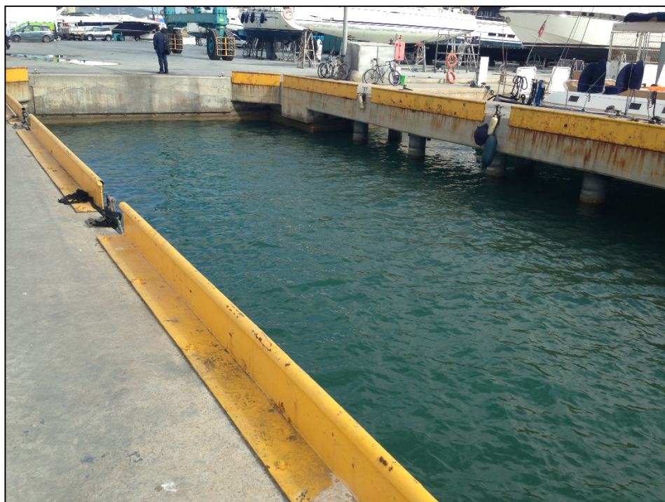
Imagen 2. Foso Travelift Varadero Ibiza
