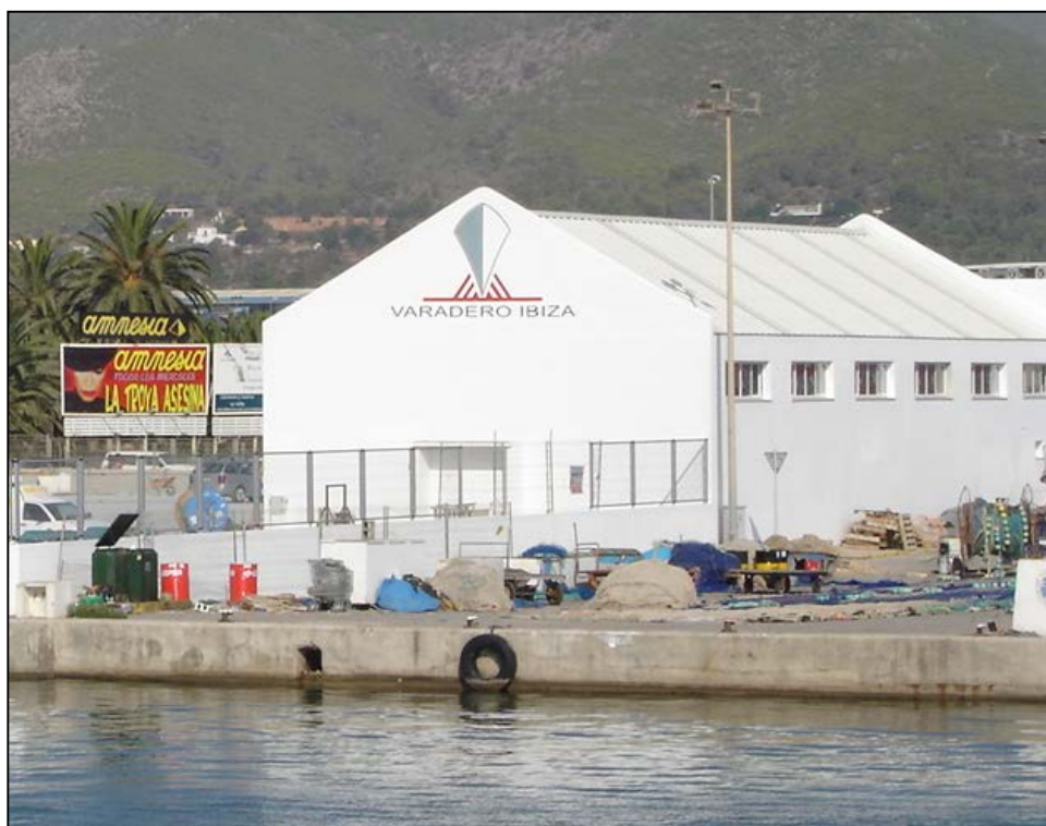
Imagen 6. Edificio de servicios
