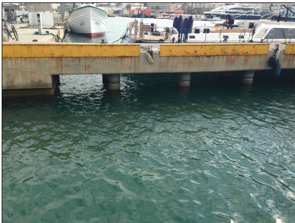
Imagen 4. Pilotes brazo foso Travelift
